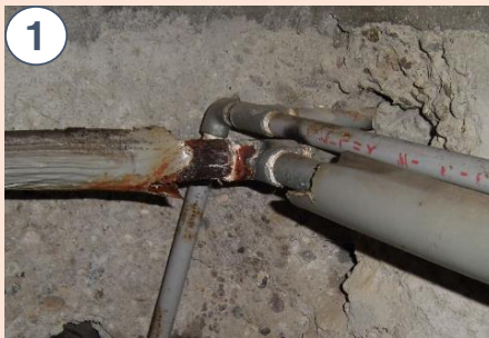
配管保温材の腐食
