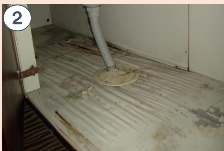
キッチン本体の劣化（底板腐食）
